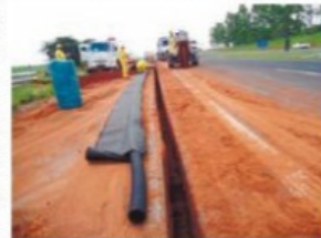
Drenajes de sub-suelos y pavimentos.
